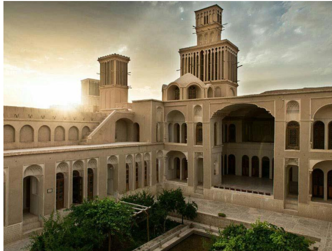
تصویر ۱. نمونه‌ای از حیاط مرکزی با جریان تهویه طبیعی
